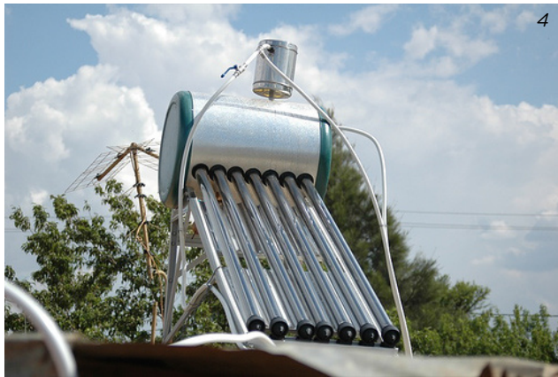
'n Son-waterverwarmer op die dak van 'n huis. Die water is in die tenk.
