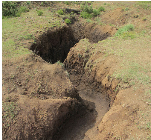
Gronderosie deur water. 2
