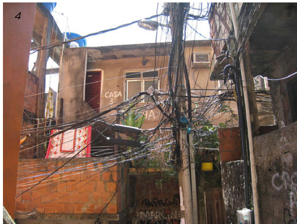
Kyk na hierdie gemors van onwettige elektriese skakelings.
