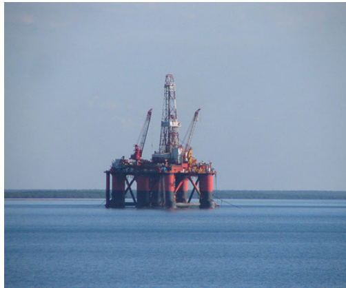
'n Olieboor in die oseaan wat 'n boor in die oseaanbodem laat sink om by die olie-afsettings uit te kom.
